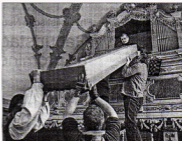
Die Windlade wurde im Dezember 2006 das erste Mal seit 1743 ausgebaut und repariert. (Foto: OTZ/Michael Matprich)
